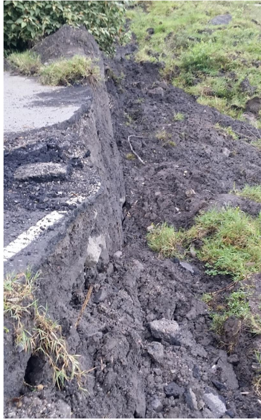
Figura 12. Pérdidas de la bancada de la carretera pavimentada Enciso –Carcasí y de la vía veredal en placa huella.
